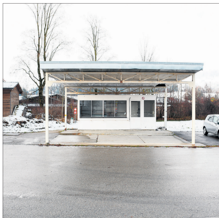
Der ehemalige Fahrzeugunterstand auf dem Areal Landbrücke.
